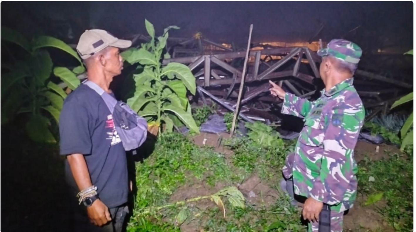
Pelda Budi Furi, anggota Koramil 04/Windusari mengecek rumah warga yang mengalami kerusakan akibat hujan disertai angin kencang
