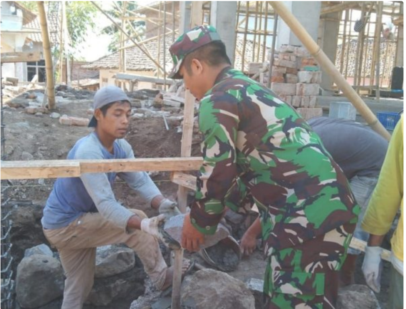
Serda Nasikin bantu pemasangan batu pondasi masjid
